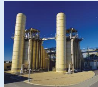
Pelican Point power station, SA (485MW)
